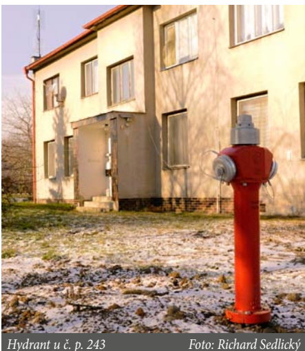
Hydrant u č. p. 243
