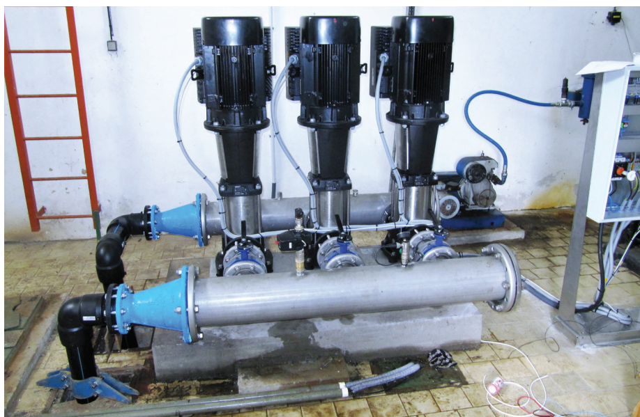
Po montáži čerpadel je zabezpečena dodávka vody o průtoku přes 40 l/s . Foto: V. Nekolný
