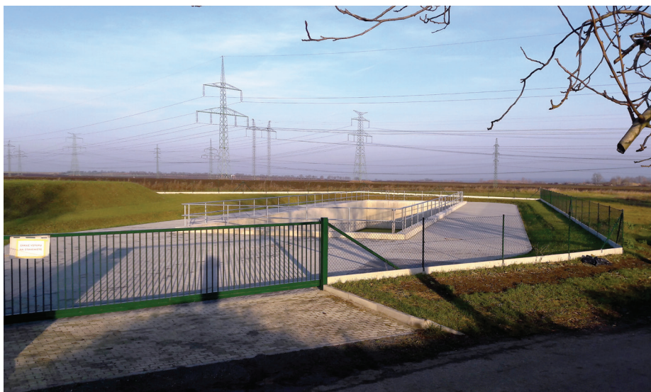
4. Dešťová usazovací nádrž u čističky odpadních vod
