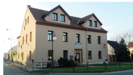
2. Rekonstrukce staré budovy školy na náměstí
