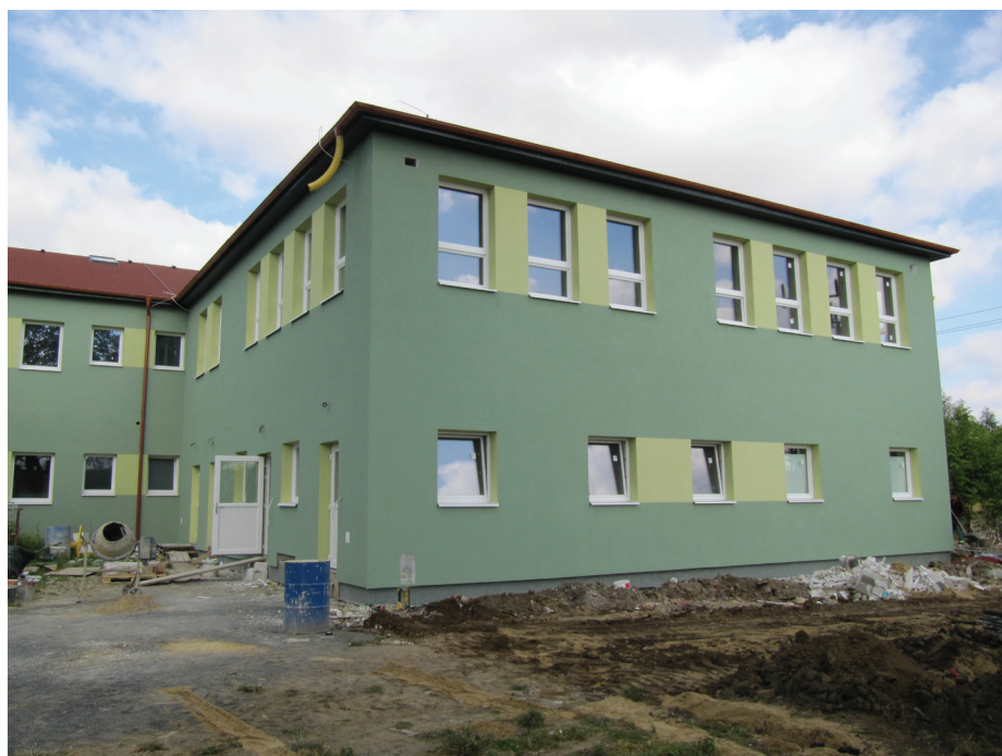
Hotová fasáda na přístavbě školy.
